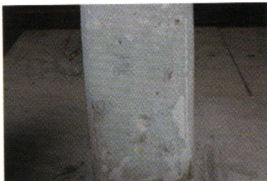
4 補修完了状況 表面研磨仕上げ
