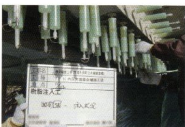
4 注入硬化養生 (IPHカプセル)
