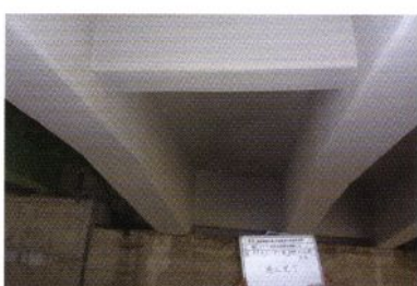
5 完成 (橋梁下部)
