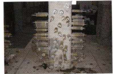
3 エポキシ樹脂低圧注入状況 IPHカプセル 注入圧力 0.06N/mm 2
