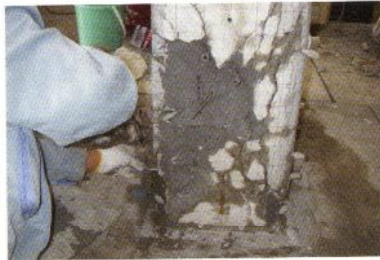
2 欠損部の修復状況 使用材料 IPH#600
